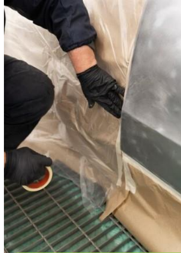
Impermeabilización y Lavado de Fachadas y Cubiertas.
